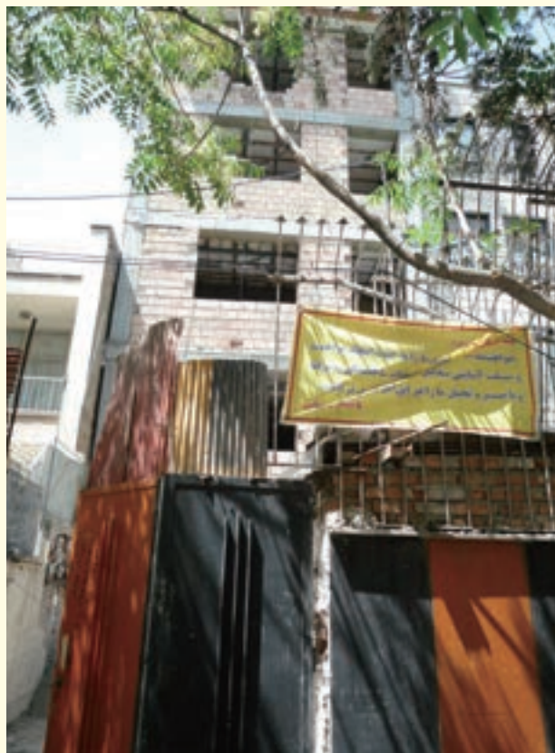
「工事中はご迷惑をおかけします」の垂れ幕とともに建築中の集合住宅。元は大きな一軒家だった(筆者撮影)。
